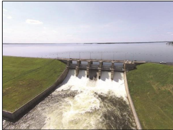
Lake Fork Spillway
